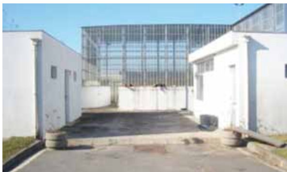
Figura 1 – Espaço selecionado para a construção da Lavandaria (antes da obra).
