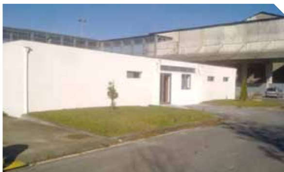
Figura 2 – Localização da Lavandaria Lipor (obra concluída).
